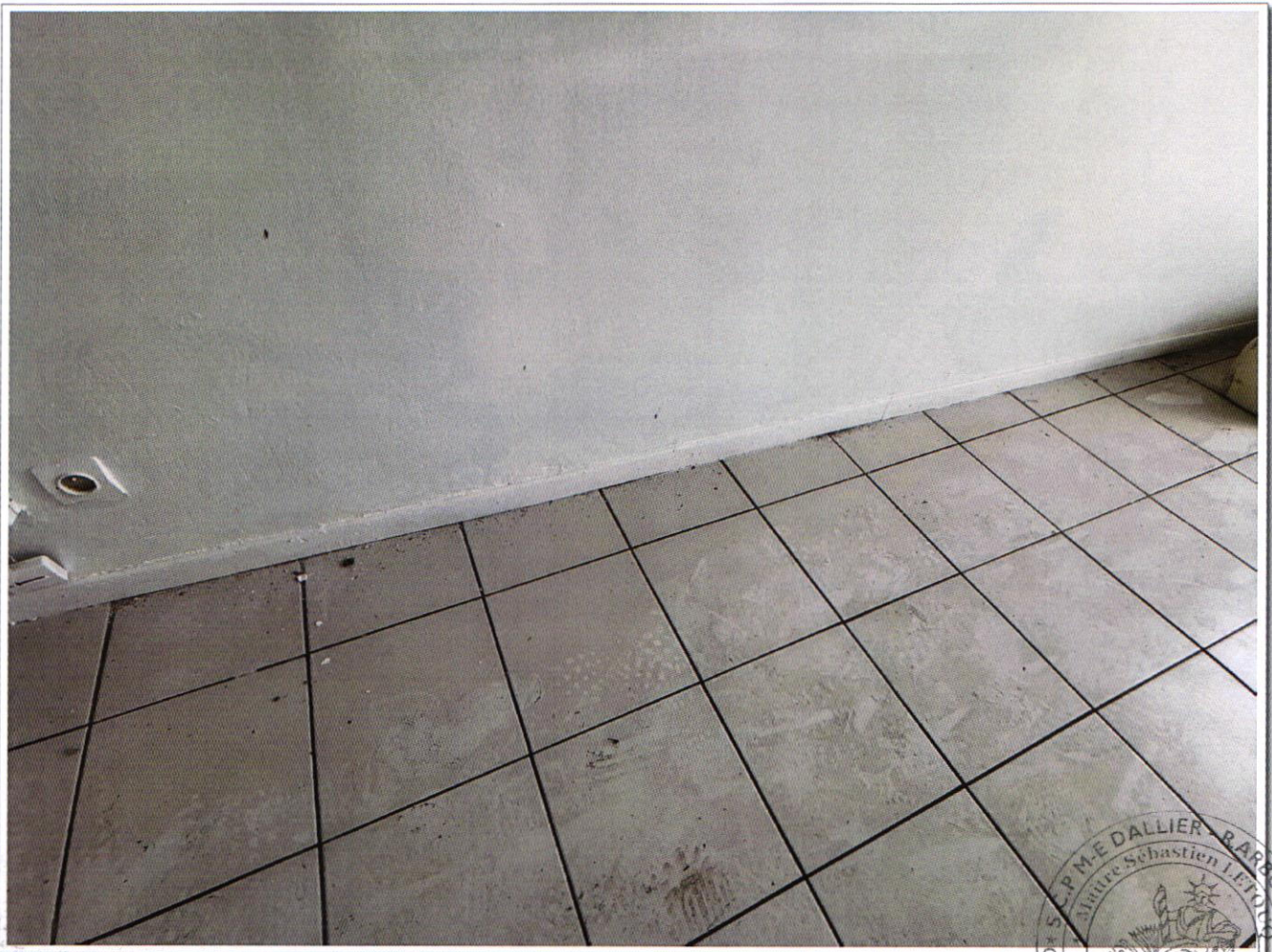
PV DESCRIPTIF 3 et 5 rue François Arago 97110 POINTE A PITRE - photo 85
