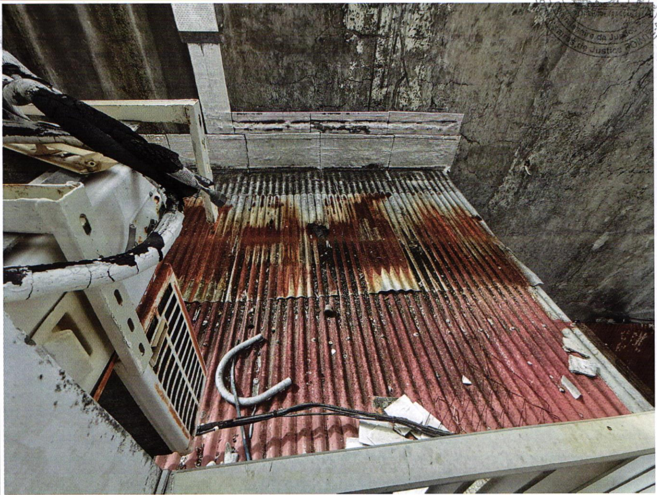
PV DESCRIPTIF 3 et 5 rue François Arago 97110 POINTE A PITRE - photo 72
