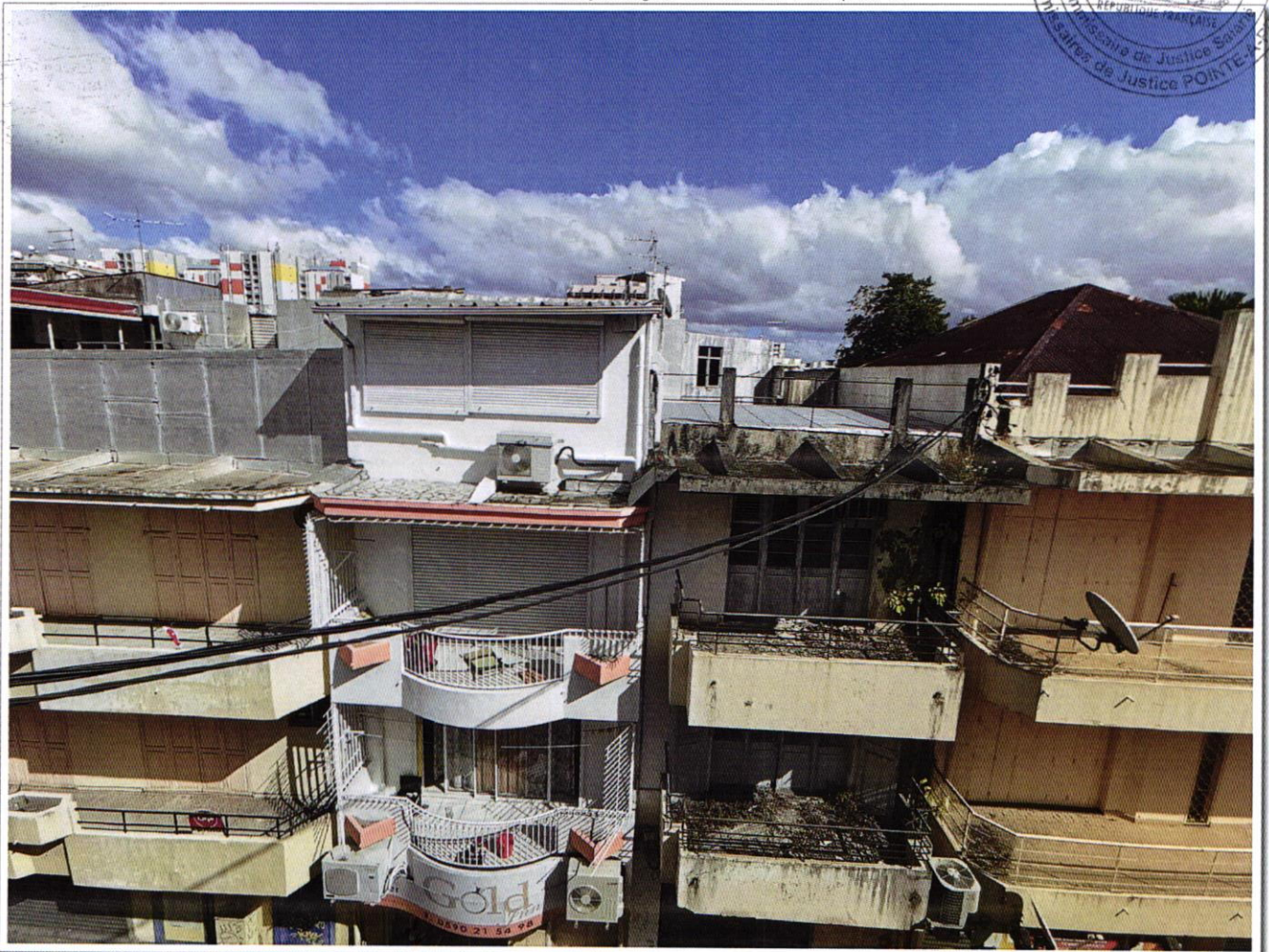
PV DESCRIPTIF 3 et 5 rue François Arago 97110 POINTE A PITRE - photo 118
