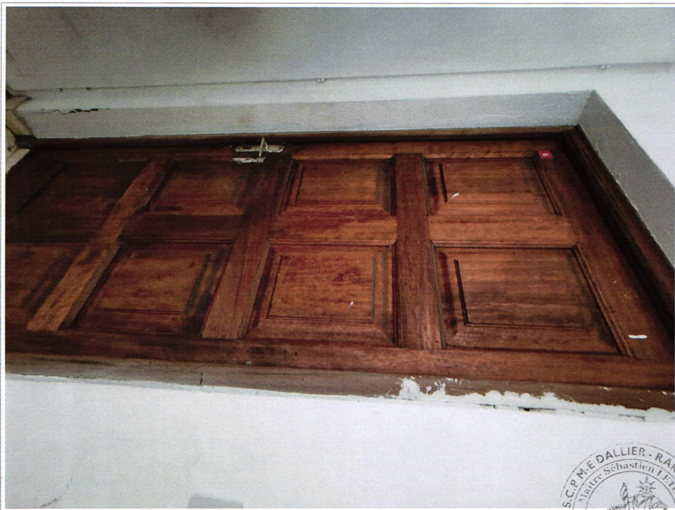
PV DESCRIPTIF 3 et 5 rue François Arago 97110 POINTE A PITRE - photo 99
