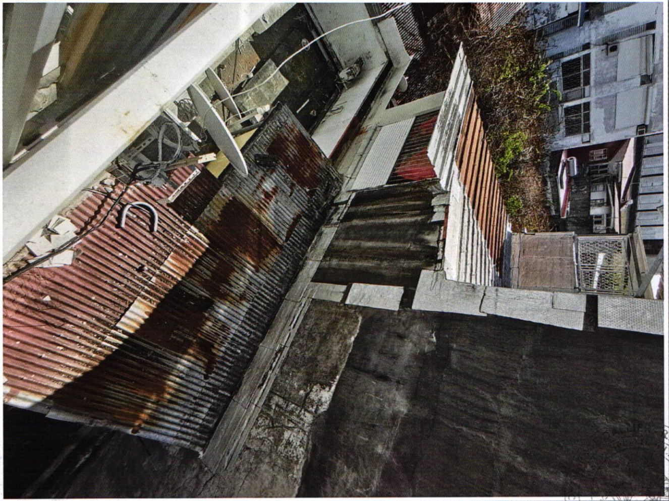
PV DESCRIPTIF 3 et 5 rue François Arago 97110 POINTE A PITRE - photo 159
