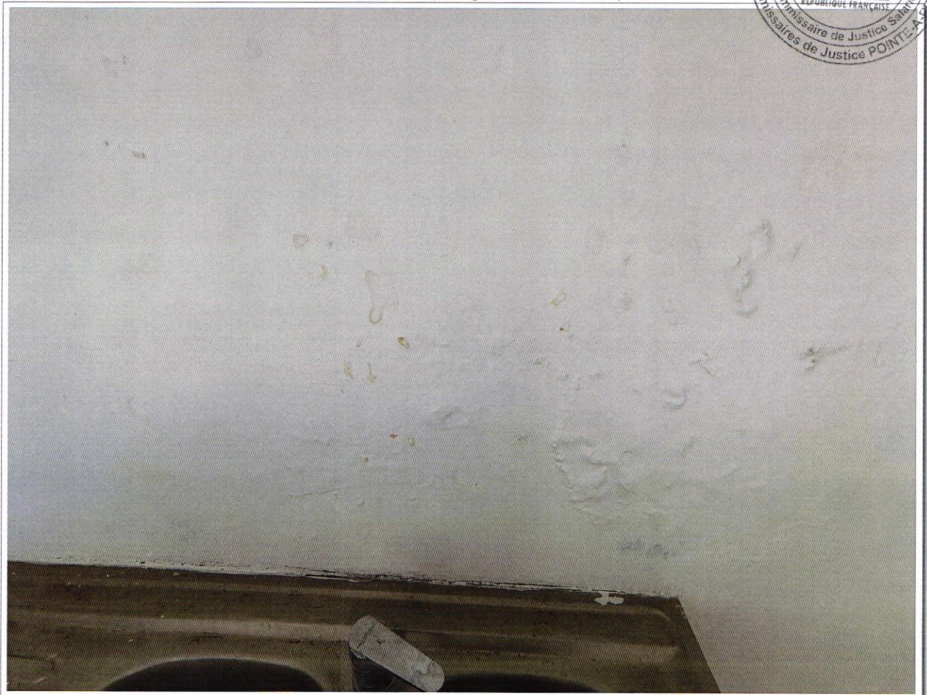
PV DESCRIPTIF 3 et 5 rue François Arago 97110 POINTE A PITRE - photo 62
