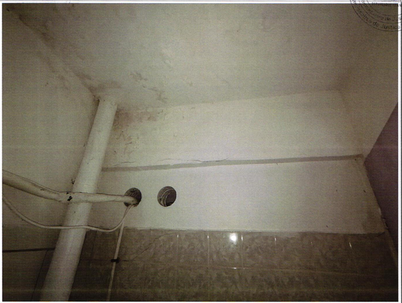
PV DESCRIPTIF 3 et 5 rue François Arago 97110 POINTE A PITRE - photo 52
