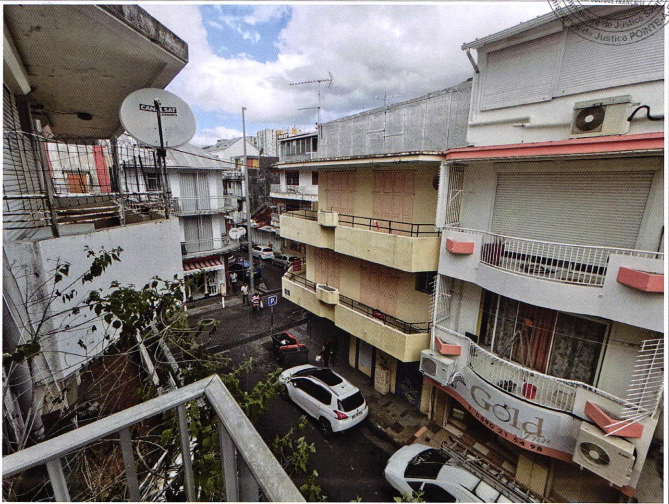
PV DESCRIPTIF 3 et 5 rue François Arago 97110 POINTE A PITRE - photo 94
