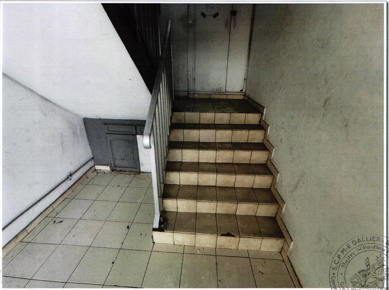
PV DESCRIPTIF 3 et 5 rue François Arago 97110 POINTE A PITRE - photo 11
