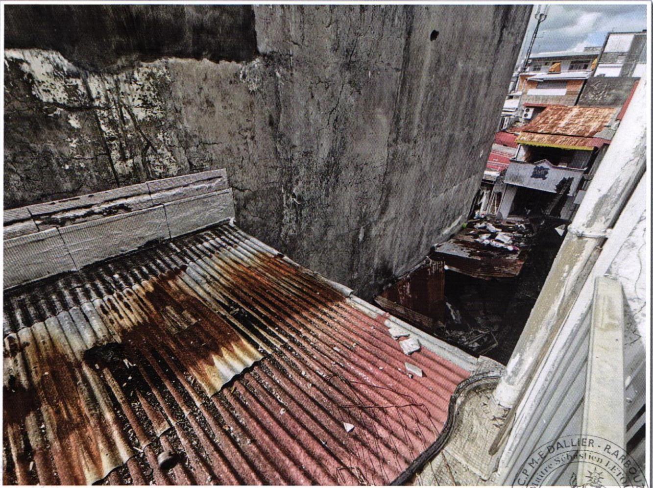
PV DESCRIPTIF 3 et 5 rue François Arago 97110 POINTE A PITRE - photo 73
