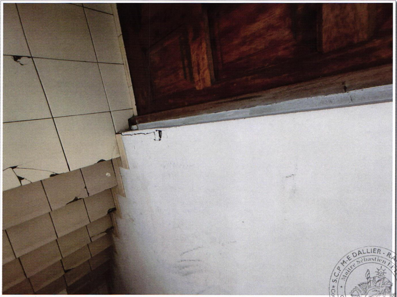
PV DESCRIPTIF 3 et 5 rue François Arago 97110 POINTE A PITRE - photo 101
