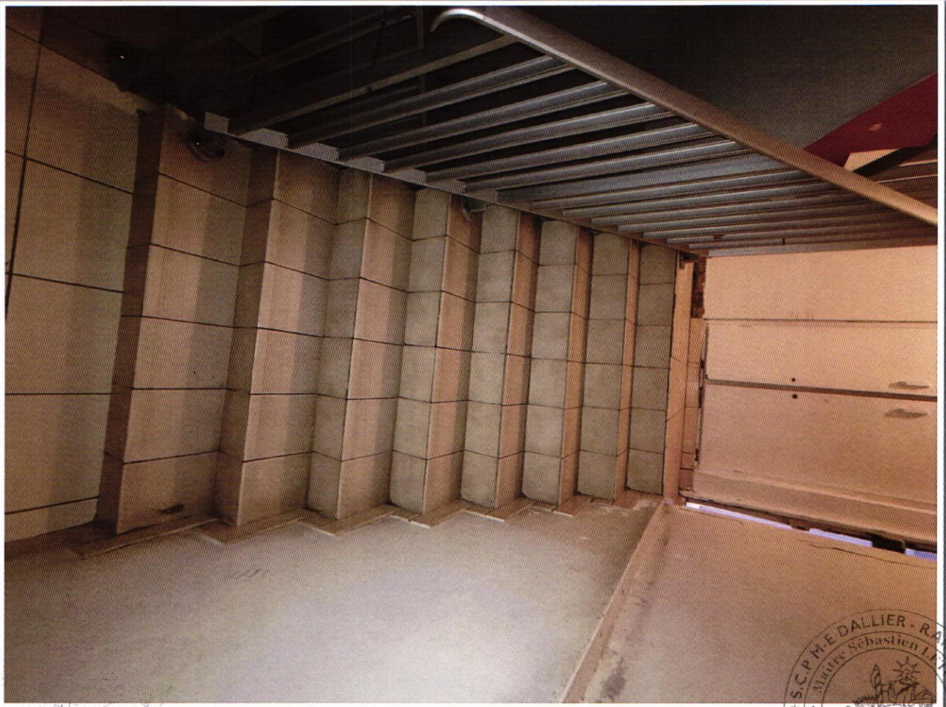
PV DESCRIPTIF 3 et 5 rue François Arago 97110 POINTE A PITRE - photo 17
