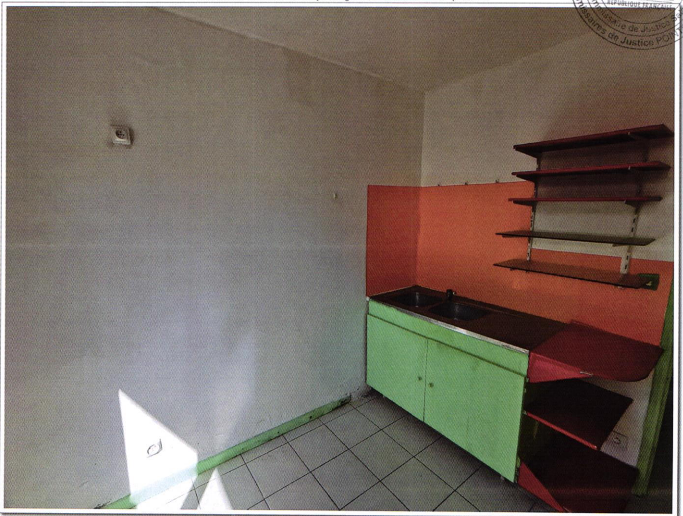
PV DESCRIPTIF 3 et 5 rue François Arago 97110 POINTE A PITRE - photo 150
