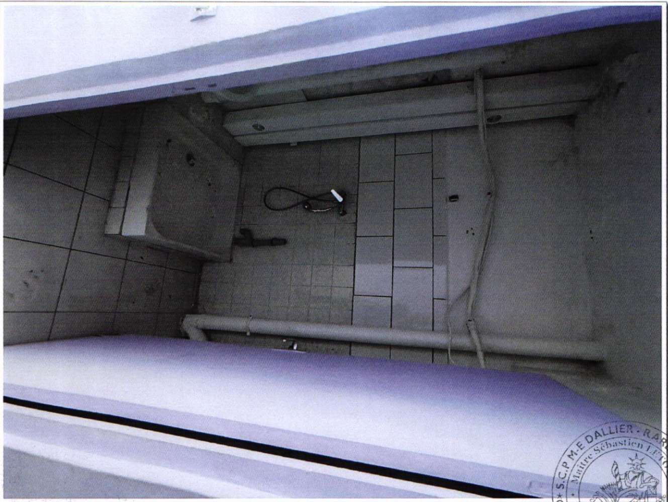
PV DESCRIPTIF 3 et 5 rue François Arago 97110 POINTE A PITRE - photo 47
