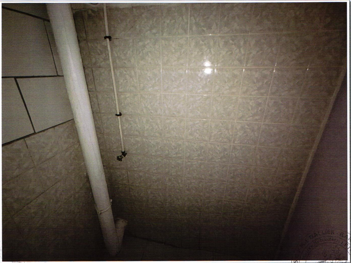
PV DESCRIPTIF 3 et 5 rue François Arago 97110 POINTE A PITRE - photo 55
