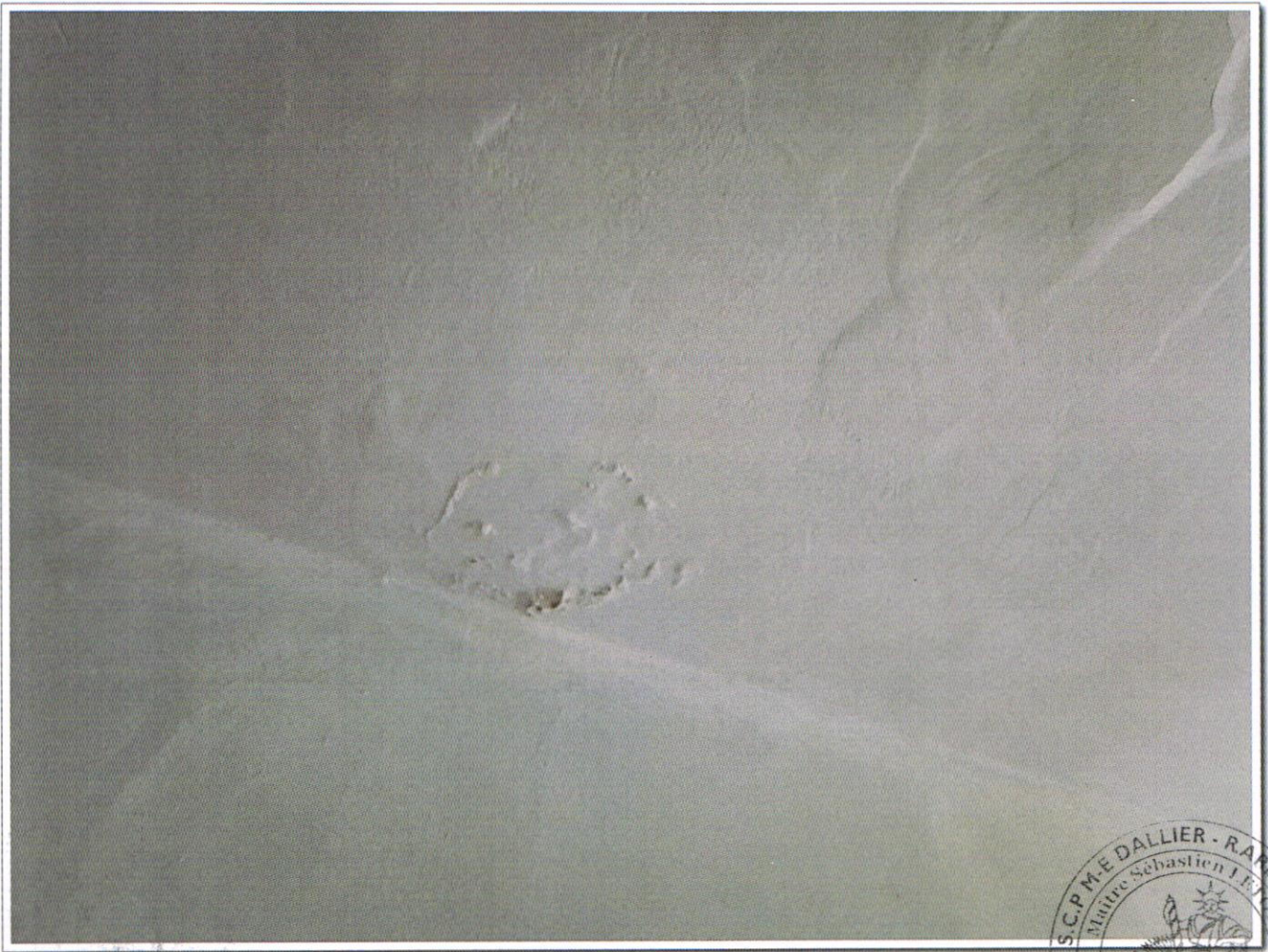
PV DESCRIPTIF 3 et 5 rue François Arago 97110 POINTE A PITRE - photo 87
