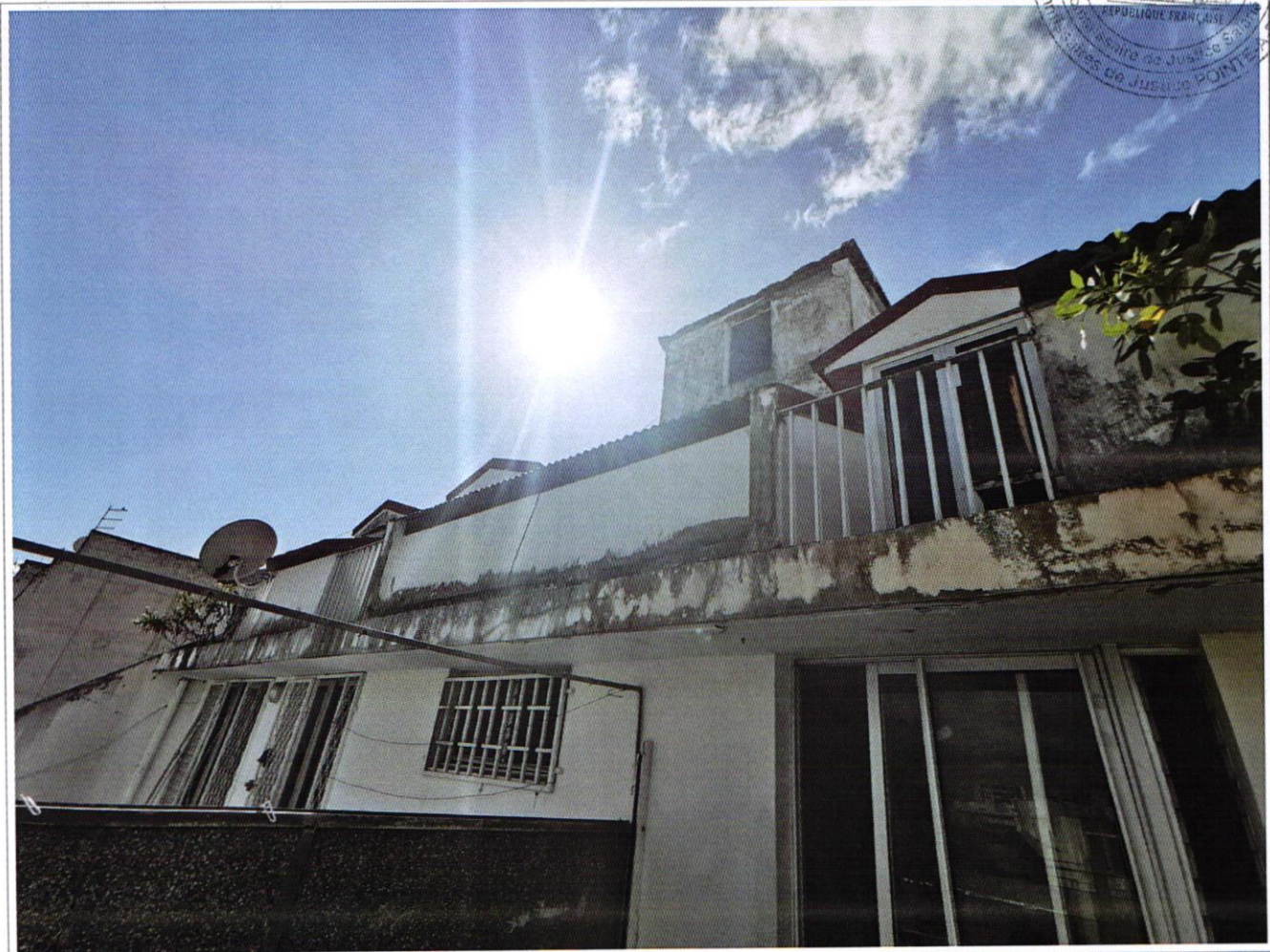
PV DESCRIPTIF 3 et 5 rue François Arago 97110 POINTE A PITRE - photo 124
