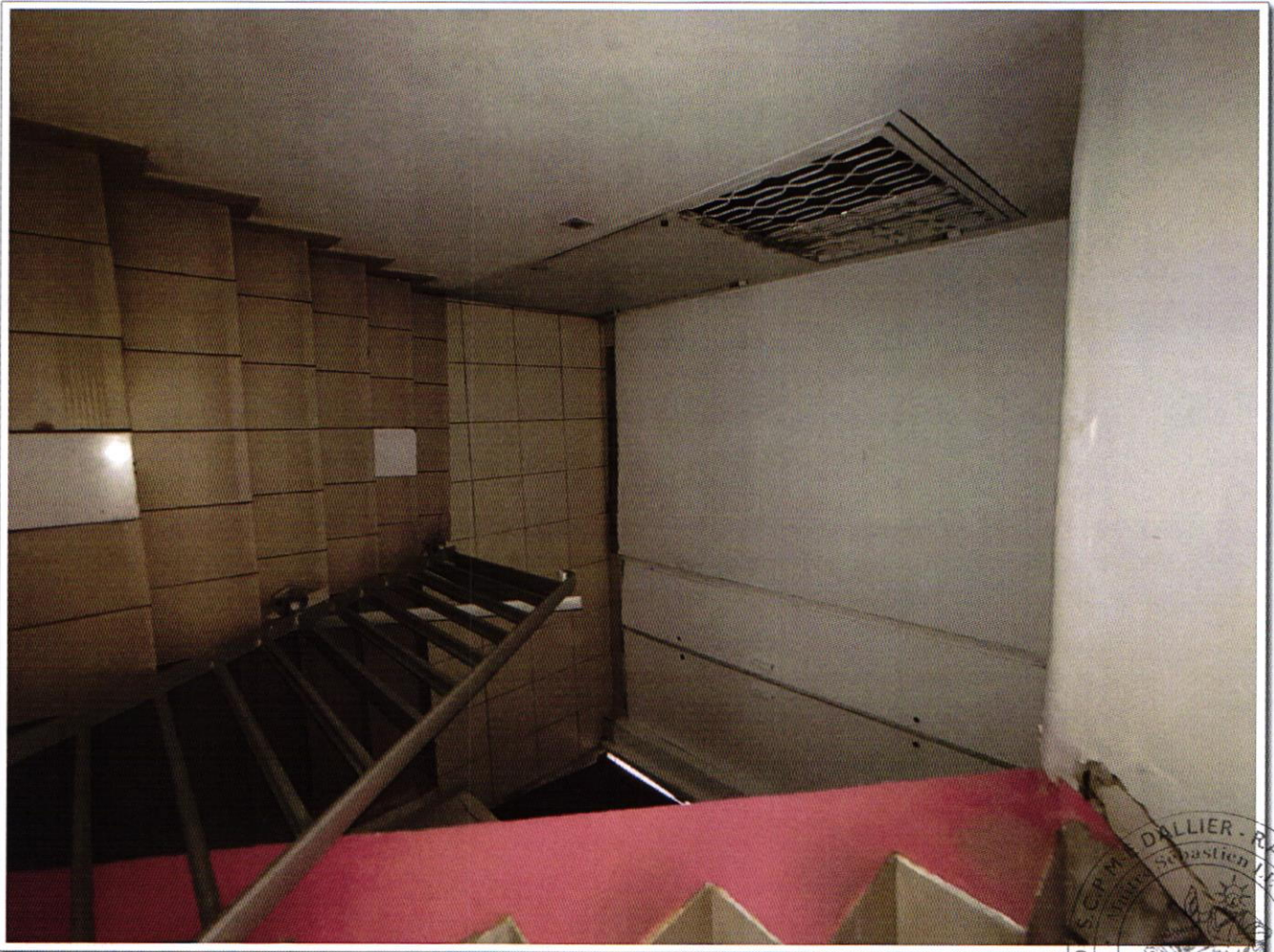
PV DESCRIPTIF 3 et 5 rue François Arago 97110 POINTE A PITRE - photo 21
