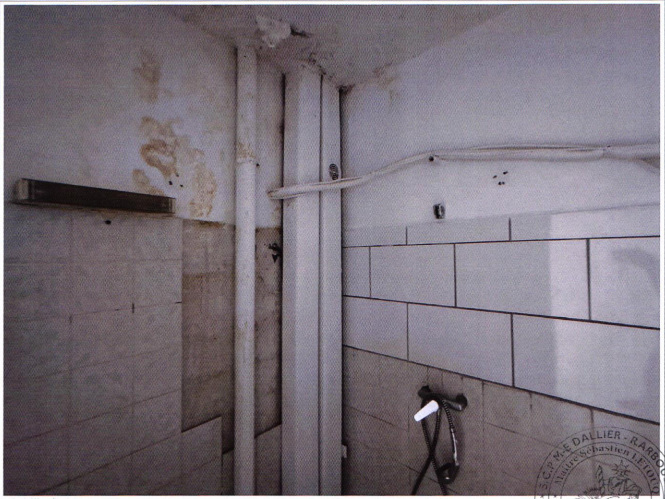
PV DESCRIPTIF 3 et 5 rue François Arago 97110 POINTE A PITRE - photo 49
