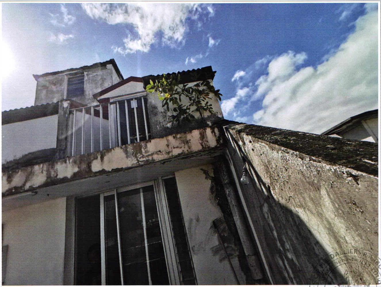
PV DESCRIPTIF 3 et 5 rue François Arago 97110 POINTE A PITRE - photo 127
