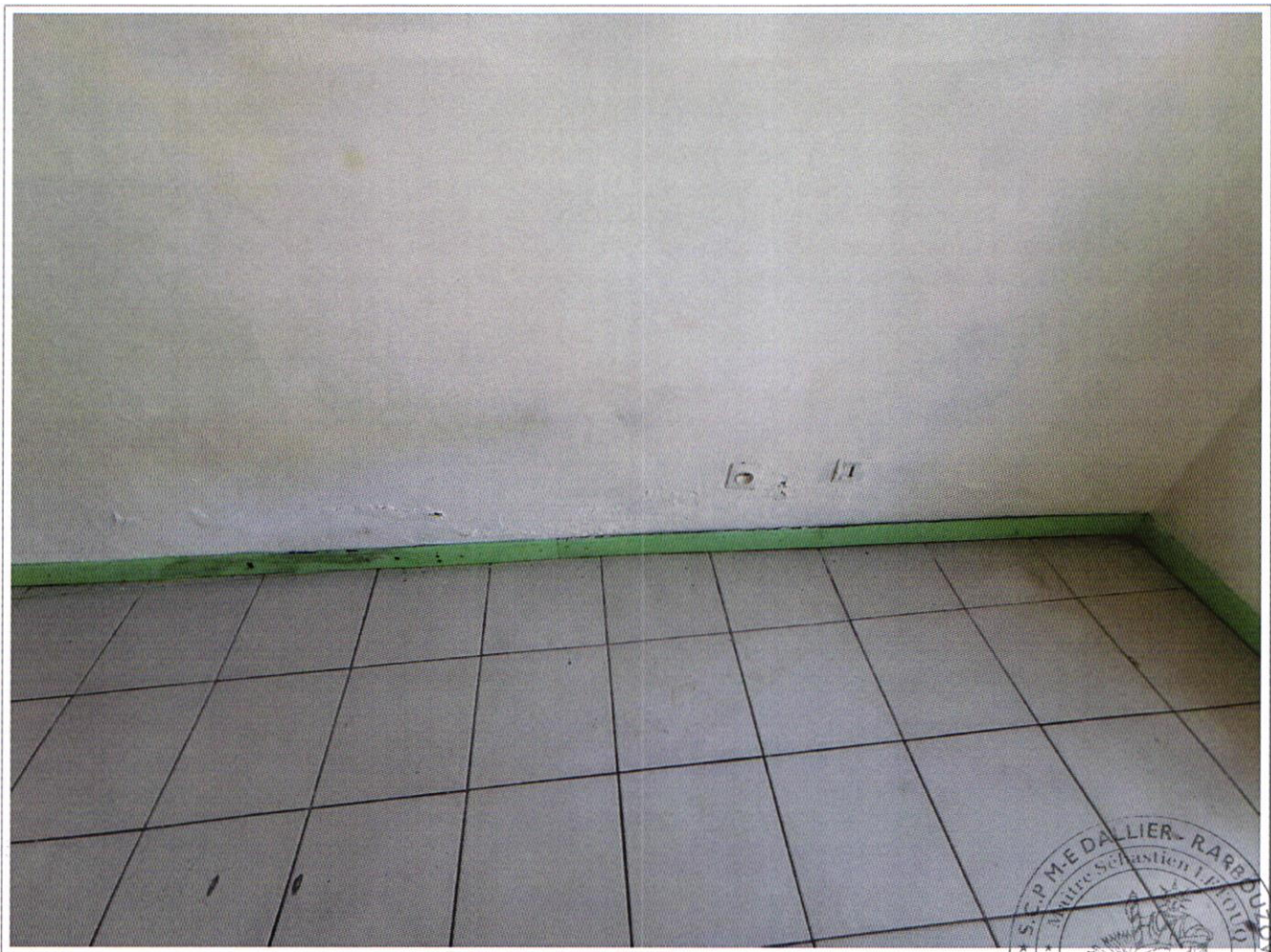
PV DESCRIPTIF 3 et 5 rue François Arago 97110 POINTE A PITRE - photo 129
