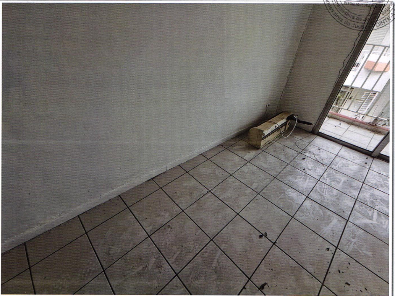
PV DESCRIPTIF 3 et 5 rue François Arago 97110 POINTE A PITRE - photo 86
