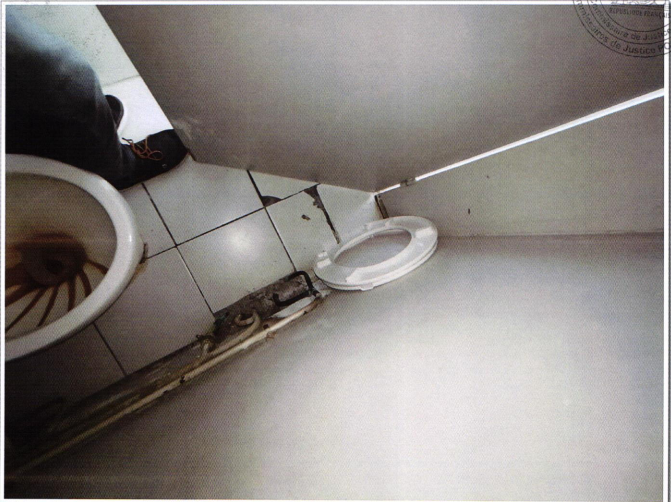
PV DESCRIPTIF 3 et 5 rue François Arago 97110 POINTE A PITRE - photo 138
