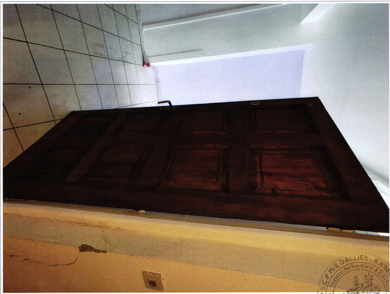
PV DESCRIPTIF 3 et 5 rue François Arago 97110 POINTE A PITRE - photo 27
