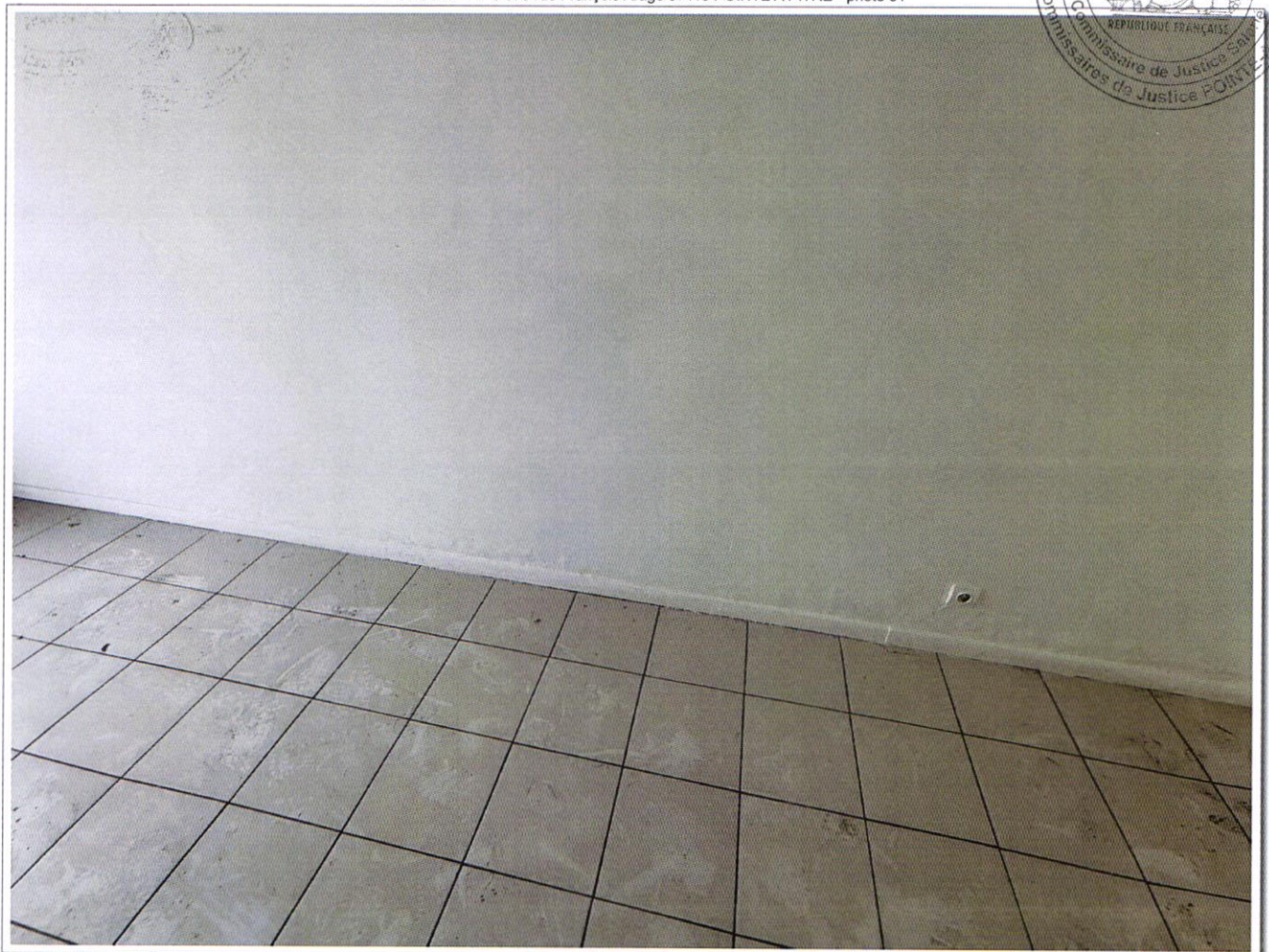
PV DESCRIPTIF 3 et 5 rue François Arago 97110 POINTE A PITRE - photo 82
