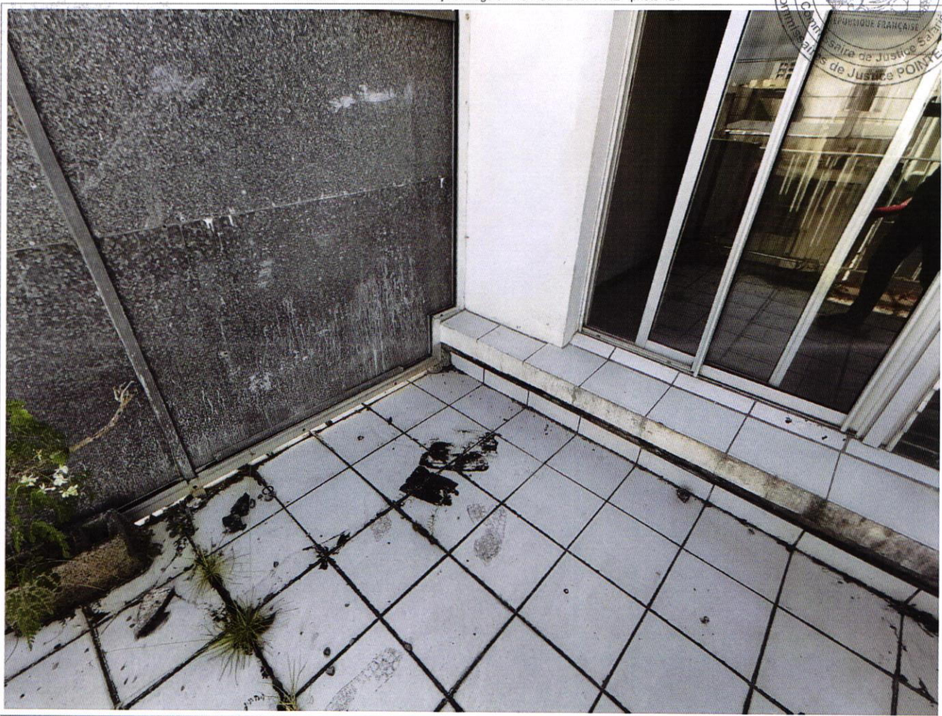
PV DESCRIPTIF 3 et 5 rue François Arago 97110 POINTE A PITRE - photo 122
