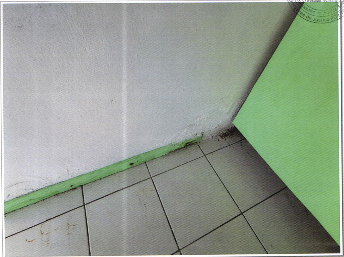
PV DESCRIPTIF 3 et 5 rue François Arago 97110 POINTE A PITRE - photo 152
