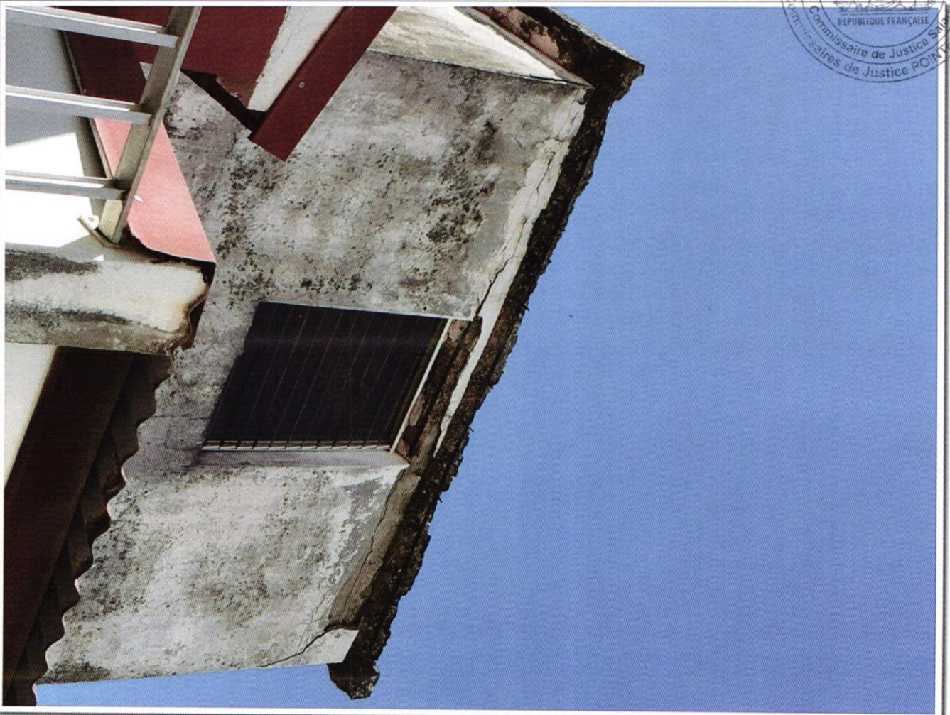
PV DESCRIPTIF 3 et 5 rue François Arago 97110 POINTE A PITRE - photo 162
