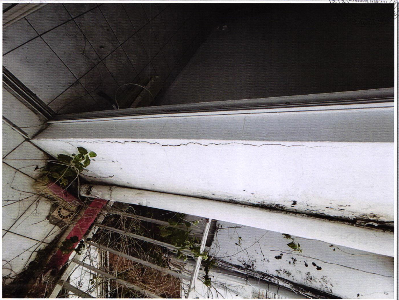
PV DESCRIPTIF 3 et 5 rue François Arago 97110 POINTE A PITRE - photo 98
