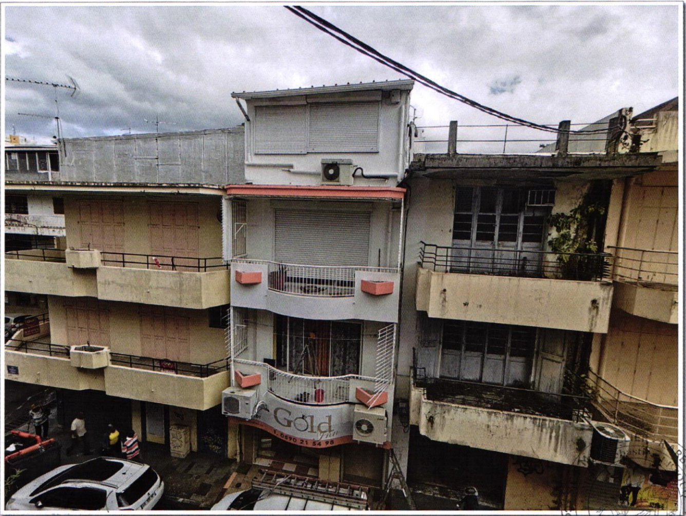
PV DESCRIPTIF 3 et 5 rue François Arago 97110 POINTE A PITRE - photo 97
