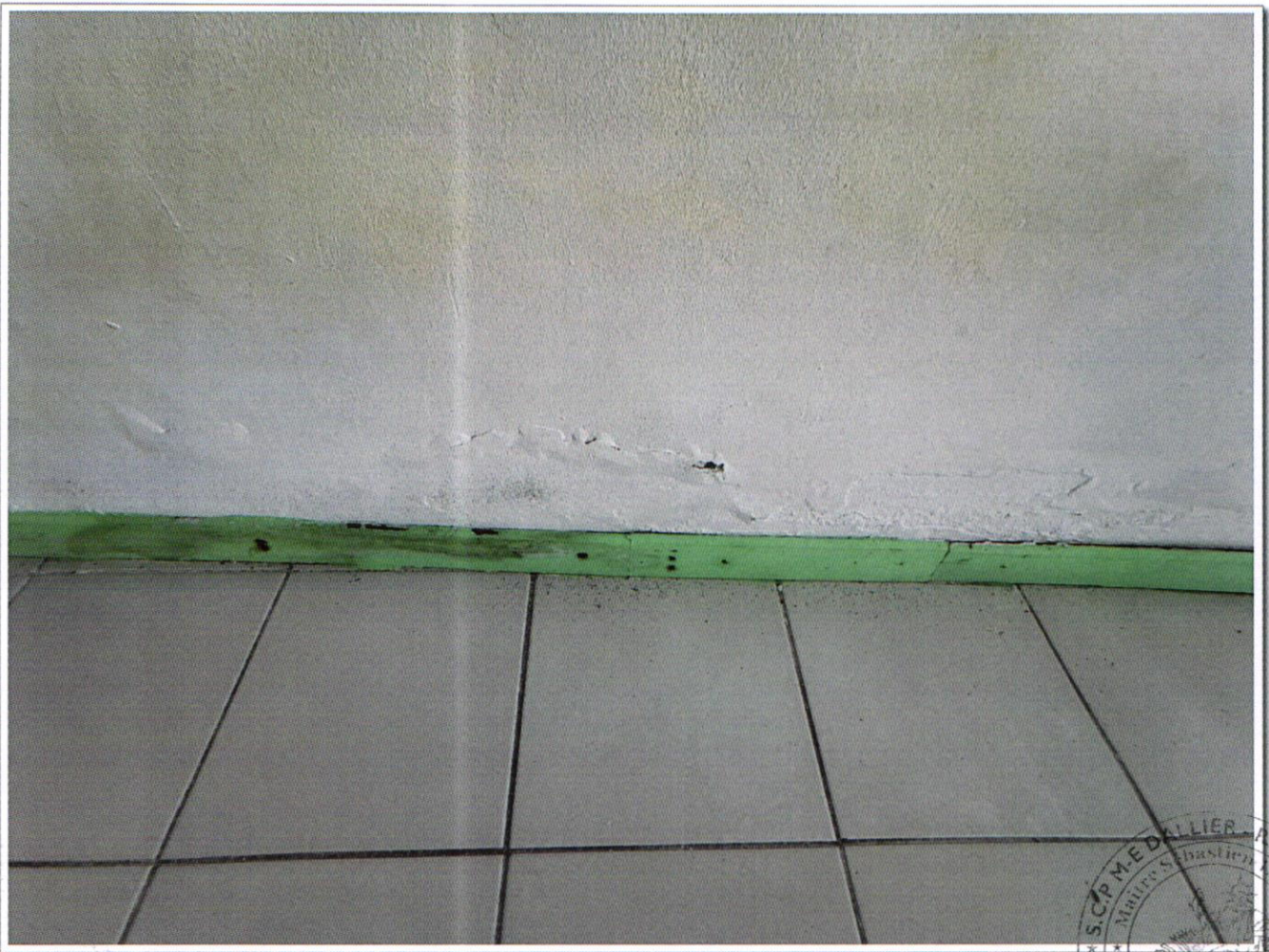
PV DESCRIPTIF 3 et 5 rue François Arago 97110 POINTE A PITRE - photo 131
