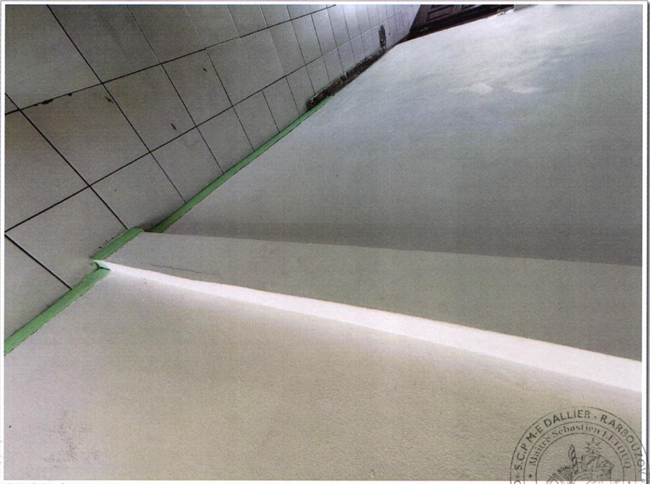
PV DESCRIPTIF 3 et 5 rue François Arago 97110 POINTE A PITRE - photo 141
