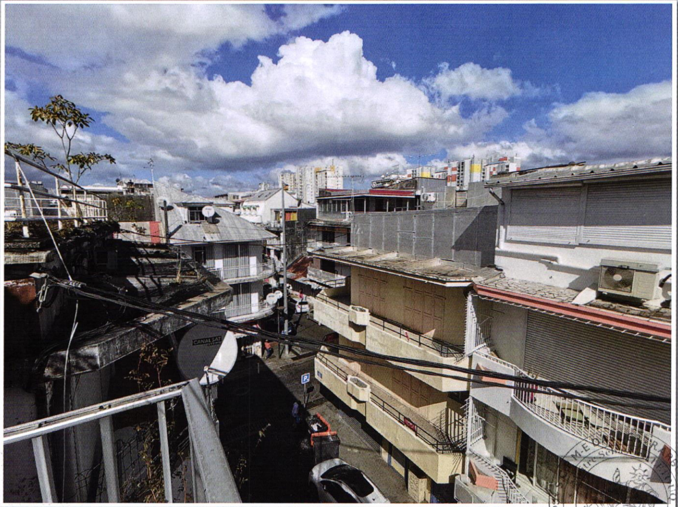
PV DESCRIPTIF 3 et 5 rue François Arago 97110 POINTE A PITRE - photo 117
