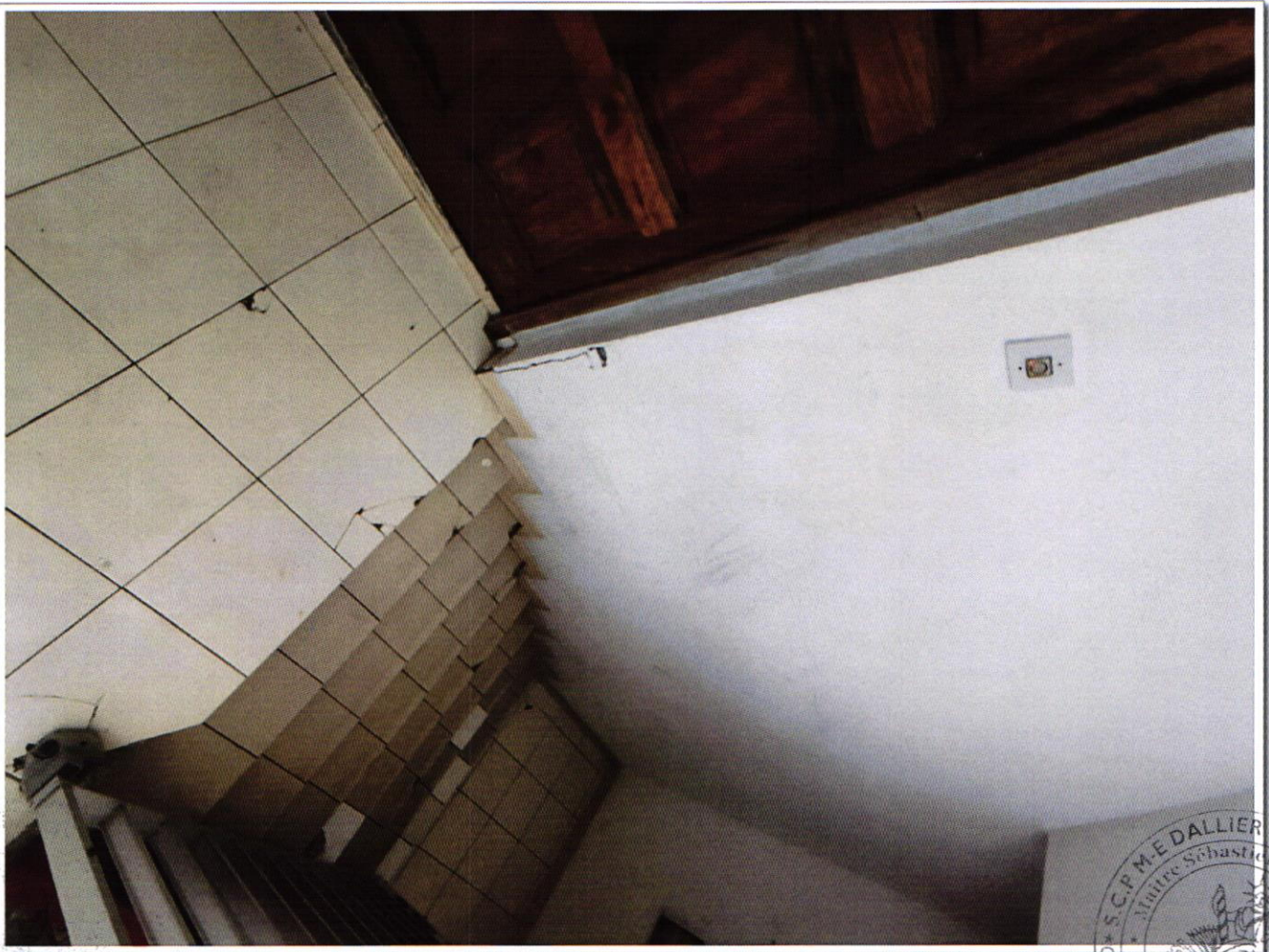
PV DESCRIPTIF 3 et 5 rue François Arago 97110 POINTE A PITRE - photo 25
