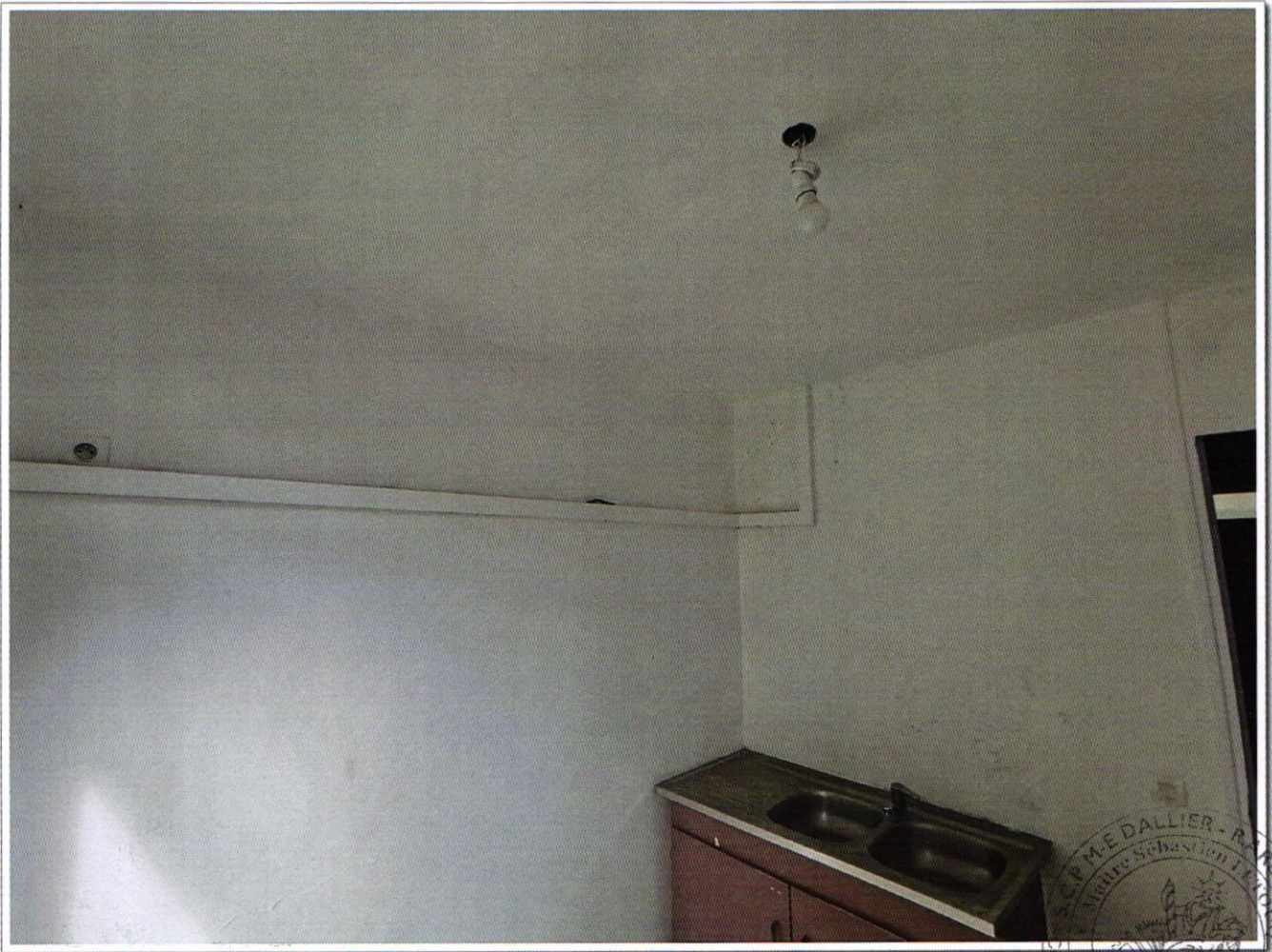
PV DESCRIPTIF 3 et 5 rue François Arago 97110 POINTE A PITRE - photo 59
