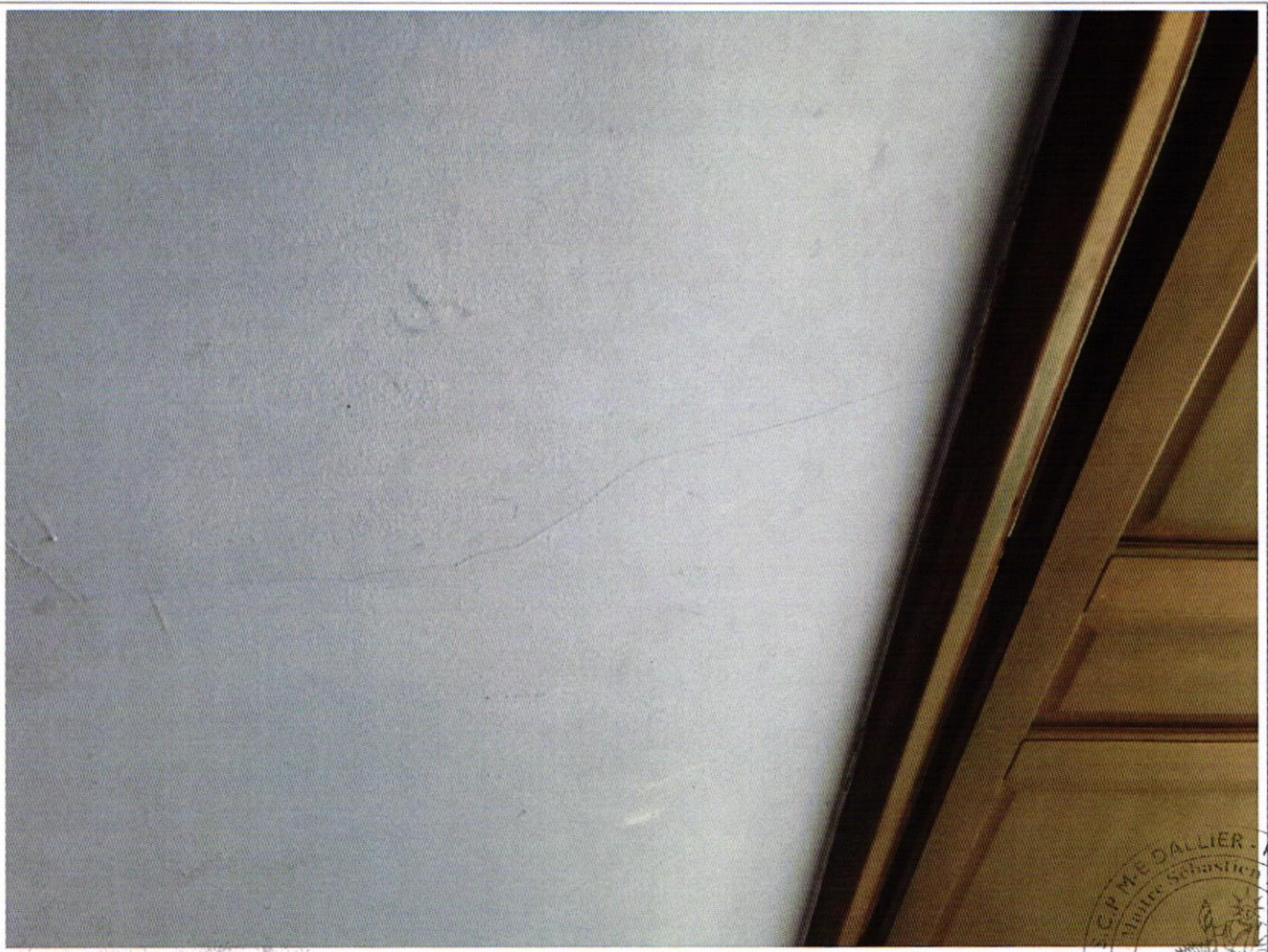
PV DESCRIPTIF 3 et 5 rue François Arago 97110 POINTE A PITRE - photo 43
