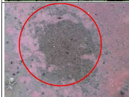
Photo n° PhTer010 Localisation : R+1 / T3 (1) à droite - Chambre 1 Ouvrage : Sol - Bois et revêtement plastique (lino) Mur - bois et peinture Plafond - bois Fenêtre - bois Parasite : Présence d'indices d'infestation de termites, Termites arboricoles Indices : Présence de vermoulures au sol
