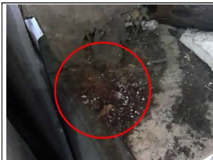
Photo n° PhTer001 Localisation : RDC - Entrée dégagement Ouvrage : Sol - béton Mur - Béton - bois et peinture Plafond - Béton - bois Porte - Métal Parasite : Présence d'indices d'infestation de termites, Termites arboricoles Indices : Présence de vermoulures (ameublement)
