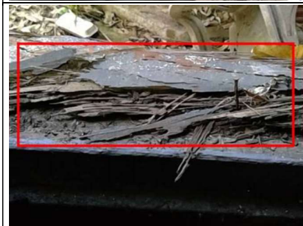
Photo n° PhTer002 Localisation : RDC - Cage d'escalier Ouvrage : Sol - béton et Carrelage Mur - Béton - bois et Peinture Plafond - bois Fenêtre - bois Porte - Bois Parasite : Présence d'indices d'infestation de termites, Termites arboricoles Indices : Altération dans le bois (châssis, porte, fenêtre, baguette)
