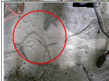
Photo n° PhTer008 Localisation : RDC / T3 (1) à droite - Salon-Séjour Ouvrage : Sol - Béton et Carrelage Mur - Béton et Peinture Plafond - bois Porte - bois Parasite : Présence d'indices d'infestation de termites, Termites arboricoles Indices : Présence de vermoulures au sol
