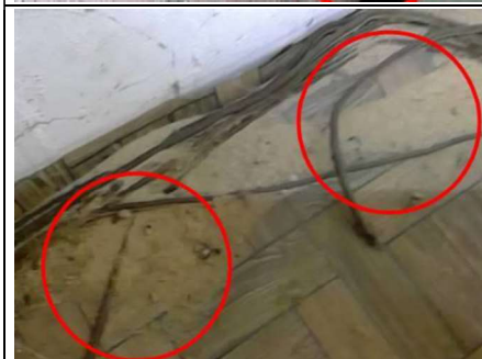
Photo n° PhTer005 Localisation : R+1 gauche - Pièce 1 Ouvrage : Sol - Bois et revêtement plastique (lino) Mur - Béton - Bois et peinture Plafond - bois Fenêtre - bois Porte - bois Parasite : Présence d'indices d'infestation de termites, Termites arboricoles Indices : Présence de vermoulures au sol
