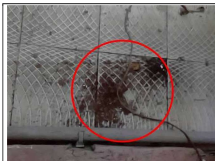
Photo n° PhTer006 Localisation : R+1 gauche - Wc Ouvrage : Sol - Béton et Carrelage Mur - Béton - Bois et peinture Plafond - bois Fenêtre - bois Porte - bois Parasite : Présence d'indices d'infestation de termites, Termites arboricoles Indices : Présence de vermoulures au sol
