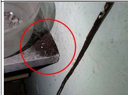
Photo n° PhTer003 Localisation : RDC - Cuisine Ouvrage : Sol - béton et Carrelage Mur - Béton et Peinture Plafond - Béton et Peinture Fenêtre - bois Parasite : Présence d'indices d'infestation de termites, Termites arboricoles Indices : Présence de vermoulures (ameublement)
