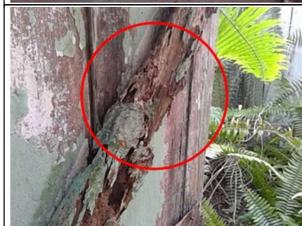
Photo n° PhTer007 Localisation : RDC / T3 (1) à droite - Entrée+kitchenette Ouvrage : Sol - Béton et Carrelage Mur - Béton - Bois et peinture Plafond - bois Fenêtre - Aluminium lames Porte - bois Parasite : Présence d'indices d'infestation de termites, Termites arboricoles Indices : Altération dans le bois (châssis, porte, fenêtre, baguette)
