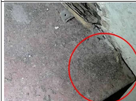
Photo n° PhTer004 Localisation : Escalier 2 Ouvrage : Sol - Bois Mur - Béton et Peinture Plafond - Bois Parasite : Présence d'indices d'infestation de termites, Termites arboricoles Indices : Présence de vermoulures au sol
