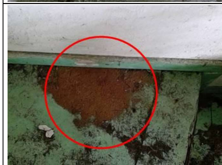
Photo n° PhTer009 Localisation : Escalier Ouvrage : Sol - Bois Mur - Béton et Peinture Plafond - bois Parasite : Présence d'indices d'infestation de termites, Termites arboricoles Indices : Présence de vermoulures au sol
