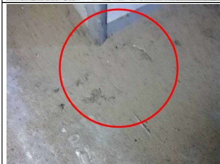
Photo n° PhTer004 Localisation : R+1 - Pièce 2 Ouvrage : Sol - Bois et revêtement plastique (lino) Mur - Bois Plafond - bois Fenêtre - bois Porte - bois Parasite : Présence d'indices d'infestation de termites, Termites arboricoles Indices : Présence de vermoulores au sol
