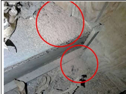
Photo n° PhTer002 Localisation : Escalier 1 Ouvrage : Sol - Bois Mur - Béton - bois et peinture Plafond - bois Parasite : Présence d'indices d'infestation de termites, Termites arboricoles Indices : Présence de vermoulores au sol
