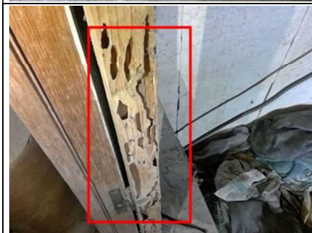
Photo n° PhTer005 Localisation : R+1 - Pièce 3 Ouvrage : Sol - Bois et revêtement plastique (lino) Mur - Bois Plafond - bois Fenêtre - bois Parasite : Présence d'indices d'infestation de termites, Termites arboricoles Indices : Altération dans le bois ( chassis, porte, fenêtre, baguette )
