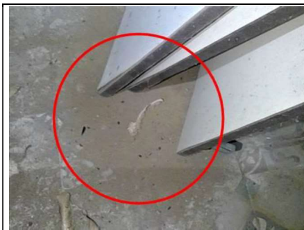
Photo n° PhTer001 Localisation : RDC - Pièce 1 Ouvrage : Sol - béton et carrelage Mur - Béton - bois et peinture Plafond - bois Plinthes - bois Fenêtre - Bois et vitrages Porte - Bois et vitrage Parasite : Présence d'indices d'infestation de termites, Termites arboricoles Indices : Présence de vermoulores au sol
