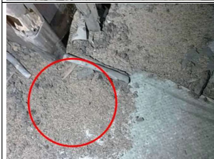
Photo n° PhTer003 Localisation : R+1 - Palier/dégagement Ouvrage : Sol - Bois et revêtement plastique (lino) Mur - Bois Plafond - bois Parasite : Présence d'indices d'infestation de termites, Termites arboricoles Indices : Présence de vermoulores au sol
