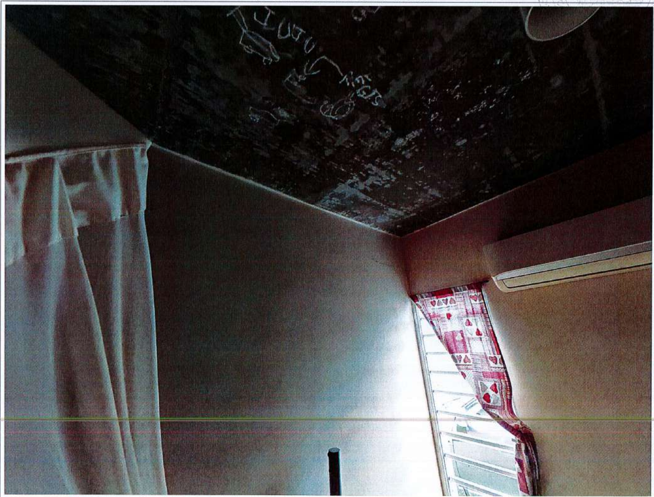
Descriptif Parcelle BI 596 BAIE-MAHAULT - Photo 72
