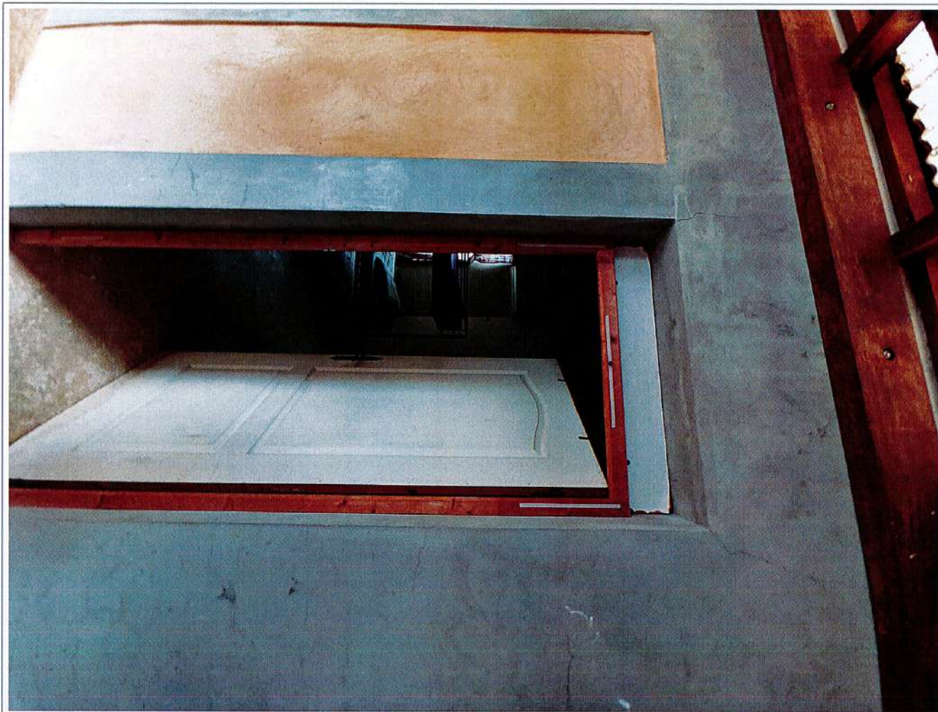
Descriptif Parcelle BI 596 BAIE-MAHAULT - Photo 67
