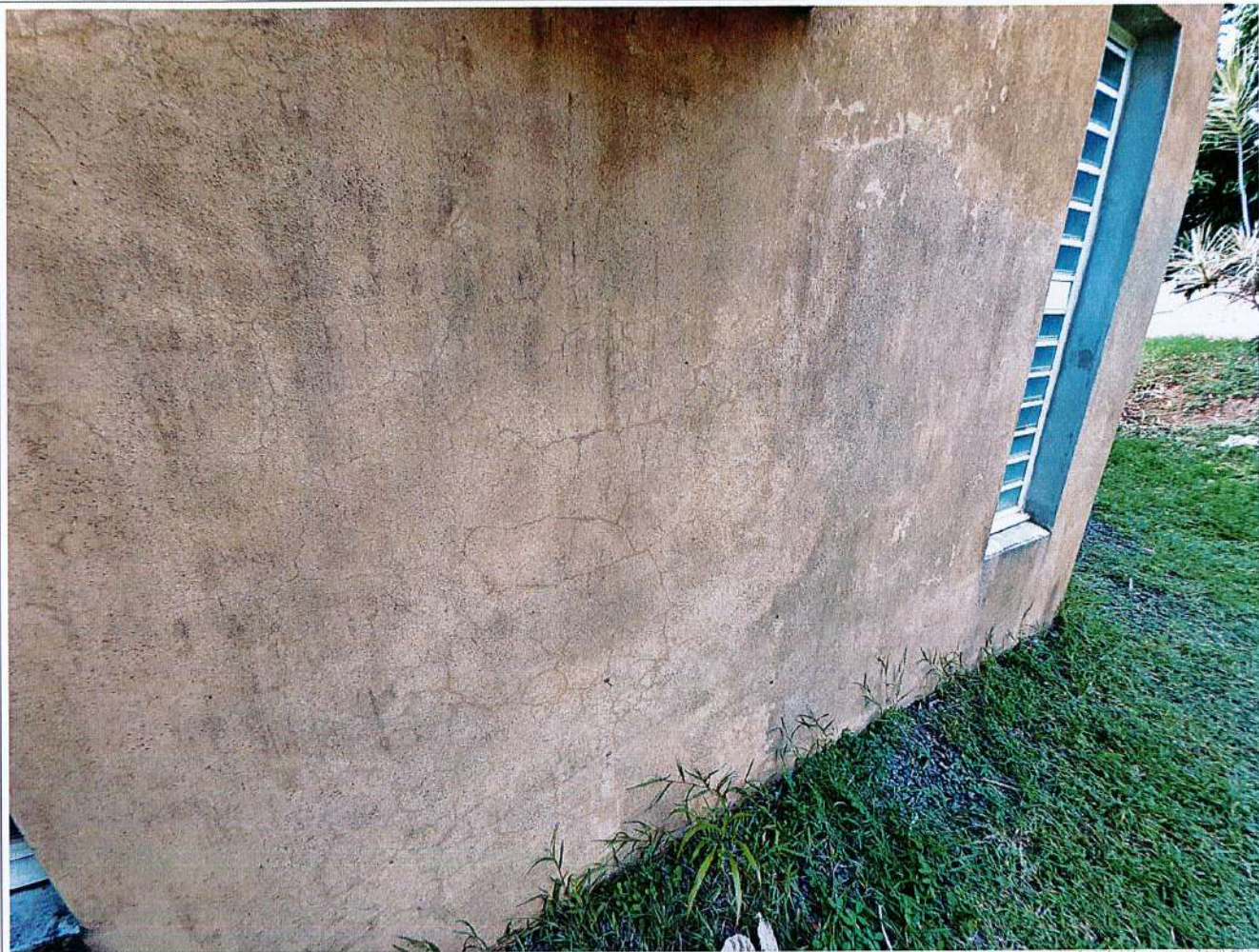
Descriptif Parcelle BI 596 BAIE-MAHAULT - Photo 23
