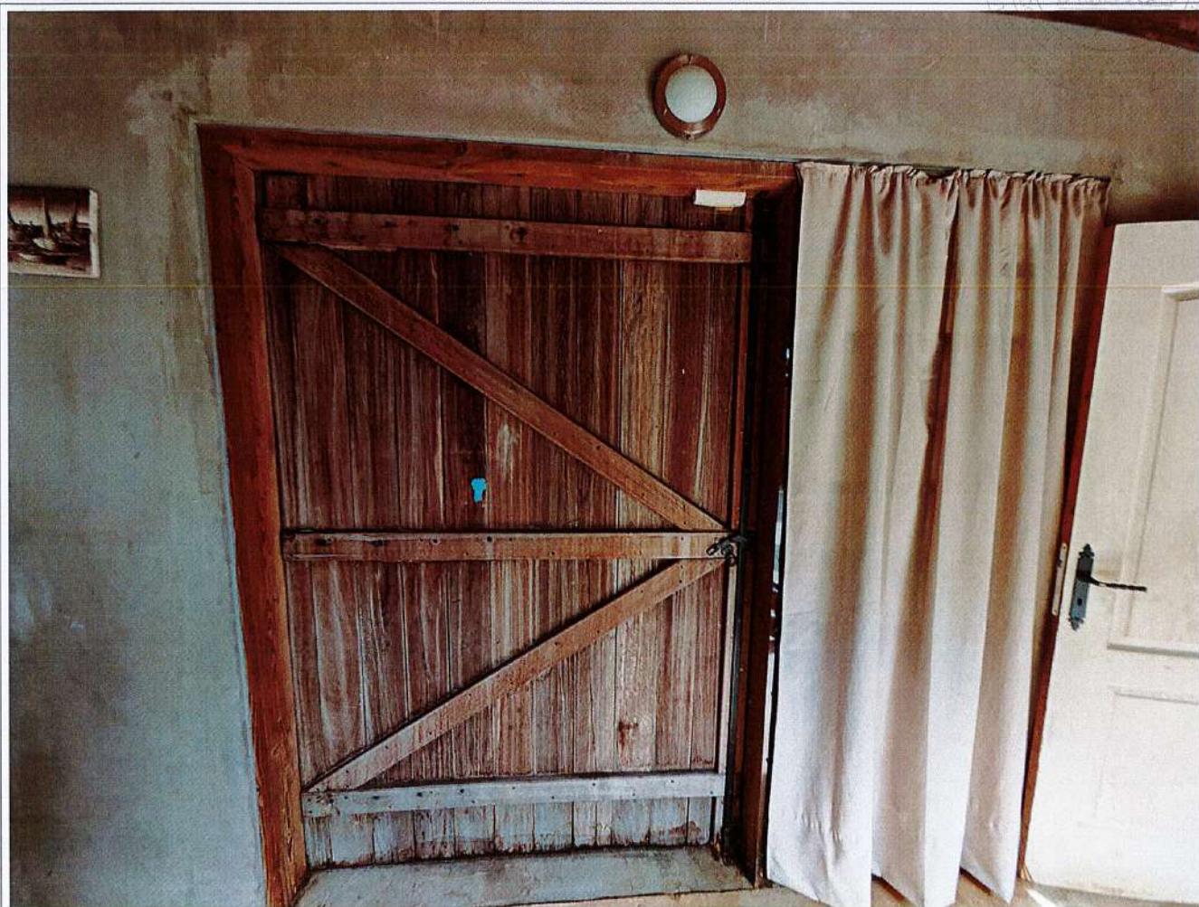
Descriptif Parcelle BI 596 BAIE-MAHAULT - Photo 50
