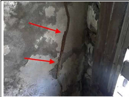
Photo n° PhTer008 Localisation : R+2 - Pièce 3 Ouvrage : Sol - Bois Mur - Béton et peinture Plafond - dalles de faux-plafond Fenêtre - bois Porte - bois Parasite : Présence d'indices d'infestation de termites, Termites arboricoles Indices : Présence de galerie(s) tunnel(s) sans activité le jour de la visite
