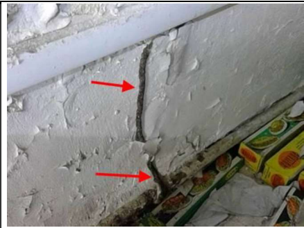
Photo n° PhTer001 Localisation : RDC - Surface de vente Ouvrage : Sol - Béton et Carrelage Mur - Béton - bois et Peinture Plafond - Lambris Bois Fenêtre - Aluminium Porte - Métal Parasite : Présence d'indices d'infestation de termites, Termites arboricoles Indices : Présence de galerie(s) tunnel(s) sans activité le jour de la visite
