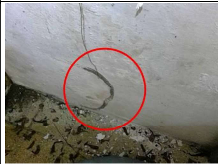
Photo n° PhTer004 Localisation : RDC - Cuisine Ouvrage : Sol - béton et carrelage Mur - Béton et Carrelage+peinture Plafond - Béton et Peinture Fenêtre - Aluminium lames verres Porte - Bois Parasite : Présence d'indices d'infestation de termites, Termites arboricoles Indices : Présence de résidus galerie(s) tunnel(s) sans activité le jour de la visite
