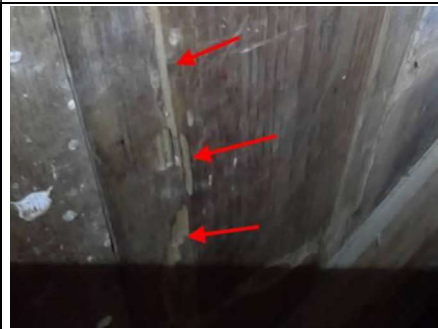
Photo n° PhTer005 Localisation : RDC - Escalier 1 Ouvrage : Sol - Béton et Carrelage Mur - Béton - bois et peinture Plafond - bois Porte - Métal Parasite : Présence d'indices d'infestation de termites, Termites arboricoles Indices : Altération dans le bois ( chassis, porte, fenêtre, baguette )
