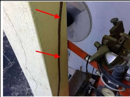
Photo n° PhTer002 Localisation : RDC - Patio Ouvrage : Sol - béton et carrelage Mur - Béton et Peinture Plafond - Tôles structure métal - béton et Peinture Parasite : Présence d'indices d'infestation de termites, Termites arboricoles Indices : Présence de galerie(s) tunnel(s) sans activité le jour de la visite
