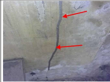
Photo n° PhTer007 Localisation : R+1 - Pièce 2 Ouvrage : Sol - Béton et Carrelage Mur - Béton et Peinture Plafond - Béton et Peinture Fenêtre - bois Porte - Bois Parasite : Présence d'indices d'infestation de termites, Termites arboricoles Indices : Présence de galerie(s) tunnel(s) sans activité le jour de la visite
