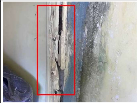
Photo n° PhTer003 Localisation : RDC - Wc Ouvrage : Sol - béton et carrelage Mur - Béton et Carrelage+peinture Plafond - Béton et Peinture Parasite : Présence d'indices d'infestation de termites, Termites arboricoles Indices : Altération dans le bois ( chassis, porte, fenêtre, baguette )
