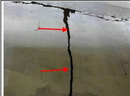
Photo n° PhTer009 Localisation : Escalier 3 Ouvrage : Sol - bois Mur - Béton - bois et peinture Plafond - bois Parasite : Présence d'indices d'infestation de termites, Termites arboricoles Indices : Présence de galerie(s) tunnel(s) sans activité le jour de la visite
