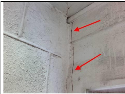
Photo n° PhTer0003 Localisation : SOUS SOL / T2 - Salle d'eau yc wc Ouvrage : Sol - Béton et Carrelage Mur - Briques et Carrelage+peinture Plafond - Béton et Peinture Fenêtre - Aluminium lames Porte - Bois Parasite : Présence d'indices d'infestation de termites, Termites arboricoles Indices : Présence de résidu galerie(s) tunnel(s) sans activité le jour de la visite
