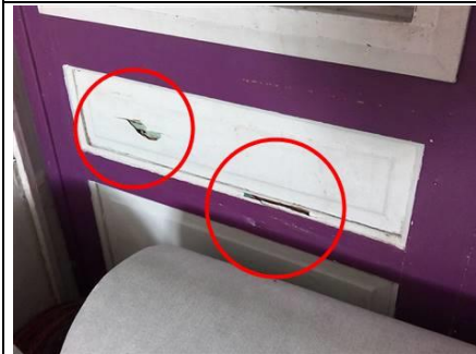
Photo n° PhTer0005 Localisation : RDJ / T4 - Salon-Séjour Ouvrage : Sol - Béton et Carrelage Mur - Béton et Peinture Plafond - Béton et Peinture Fenêtre - Bois et vitrage Porte - Bois et vitrage, Charpente, Charpente, Charpente Parasite : Présence d'indices d'infestation de termites, Termites de bois sec Indices : Altérations dans le bois
