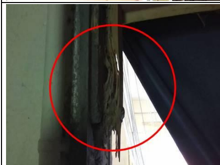
Photo n° PhTer0002 Localisation : SOUS SOL / T2 - Chambre Ouvrage : Sol - Béton et Carrelage Mur - Briques et Peinture Plafond - Béton et Peinture Plinthes - Carrelage Fenêtre - Aluminium lames Porte - Bois Parasite : Présence d'indices d'infestation de termites, Termites de bois sec Indices : Altérations dans le bois ( châssis, porte, fenêtre, baguette )
