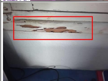
Photo n° PhTer0007 Localisation : RDC / T4 - Chambre 2 Ouvrage : Sol - Béton et Carrelage Mur - Béton et Peinture Plafond - Béton et Peinture Plinthes - Carrelage Fenêtre - Aluminium lames Porte - Bois Parasite : Présence d'indices d'infestation de termites, Termites de bois sec Indices : Altérations dans le bois ( châssis, porte, fenêtre, baguette )
