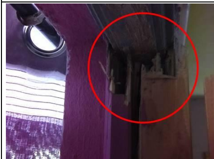
Photo n° PhTer0006 Localisation : RDJ / T4 - Chambre 3 Ouvrage : Sol - Béton et Carrelage Mur - Béton et Peinture Plafond - Béton et Peinture Fenêtre - Aluminium lames Porte - Bois Parasite : Présence d'indices d'infestation de termites, Termites de bois sec Indices : Altérations dans le bois ( châssis, porte, fenêtre, baguette )
