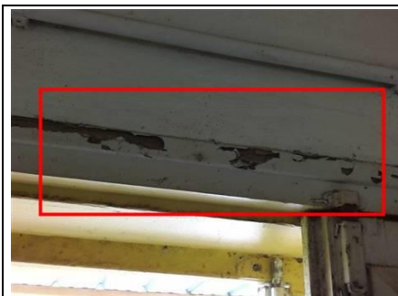
Photo n° PhTer0001 Localisation : SOUS SOL / T2 - Salon,Séjour-Cuisine Ouvrage : Sol - Béton et Carrelage Mur - Briques et Carrelage+peinture Plafond - Béton et Peinture Plinthes - Carrelage Fenêtre - Aluminium lames Porte - Bois et vitrage Parasite : Présence d'indices d'infestation de termites, Termites de bois sec Indices : Altérations dans le bois ( châssis, porte, fenêtre, baguette )
