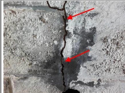
Photo n° PhTer0004 Localisation : RDJ / T4 - Terrasse Ouvrage : Sol - Béton et Carrelage Mur - Béton, Briques et Peinture Plafond - Béton et Peinture Parasite : Présence d'indices d'infestation de termites, Termites arboricoles Indices : présence de galerie(s) tunnel(s) sans activité de termites le jour de la visite
